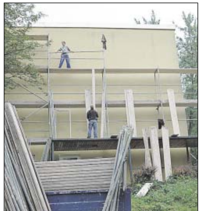
Die Baugerüste stehen schon: Die Turnhalle der Regenbogenschule wird renoviert. Foto: Sebastian Grote
